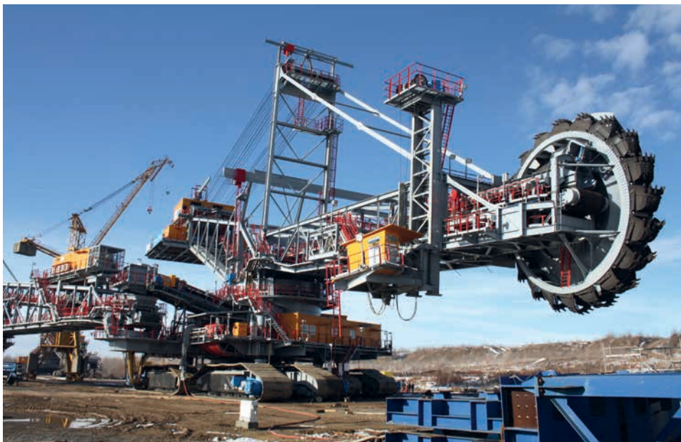
■ Нови багер „SCHrS 1400“ монтиран
